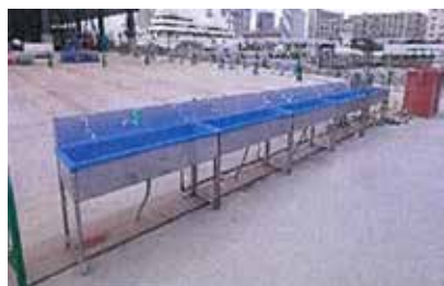
現場の手洗い場所の増設
